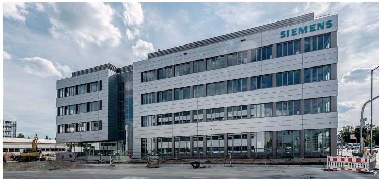
Abbildung 3: Ansicht fertiges Laborgebäude
